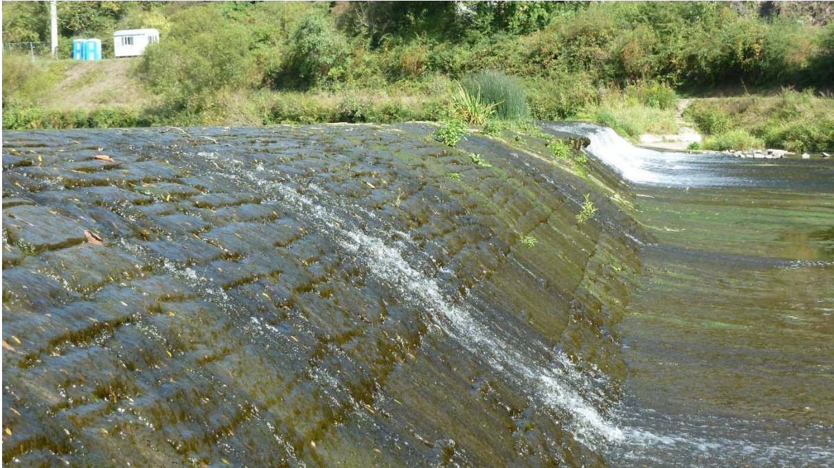
Bild 2: Überströmung des Lahnwehres bei kleinen Abflüssen
