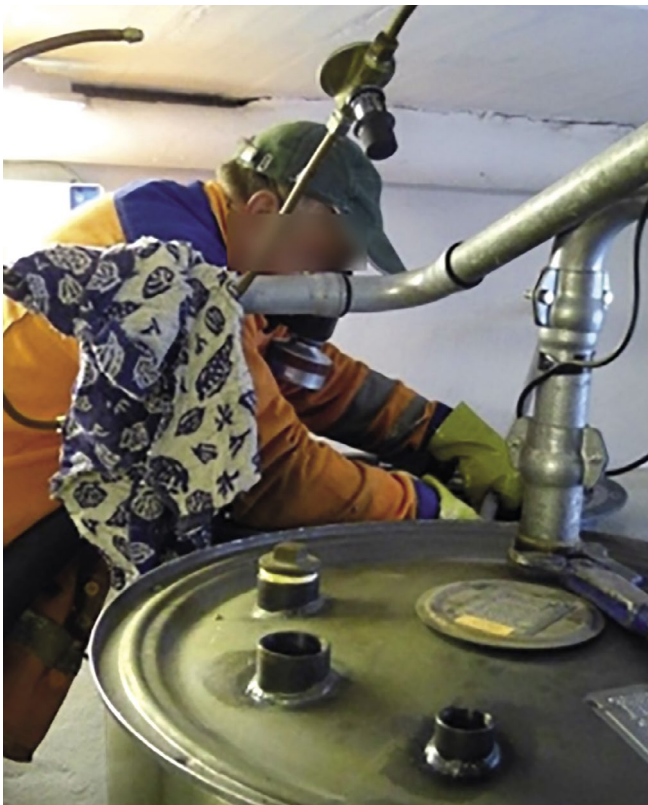
Abbildung 26: Reinigung eines Kellertanks
