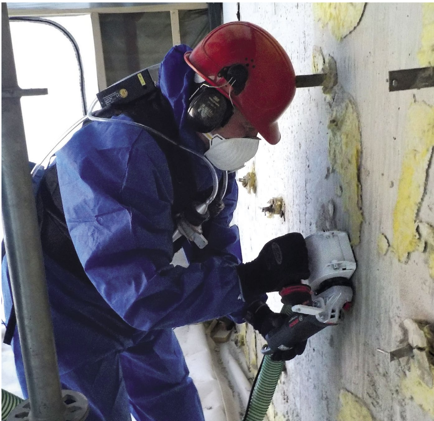
Abbildung 3: Neben leicht erkennbaren asbesthaltigen Materialien wie Spritzasbest, Asbestzement oder Floor-Flex-Platten können auch Putze, Spachtelmassen und Kleber asbesthaltig sein. Bei der Entfernung oder Bearbeitung solcher Materialien können Beschäftigte zusätzlich zu der auftretenden Staub- und Quarzfeinstaubbelastung auch gegenüber Asbest-Fasern exponiert sein. Durch messtechnische Untersuchungen soll die Gefahrstoffbelastung bei der Bearbeitung asbesthaltiger Bauteile, z. B. bei der Entfernung des asbesthaltigen Klebers von Fassadenoberflächen, ermittelt werden.
