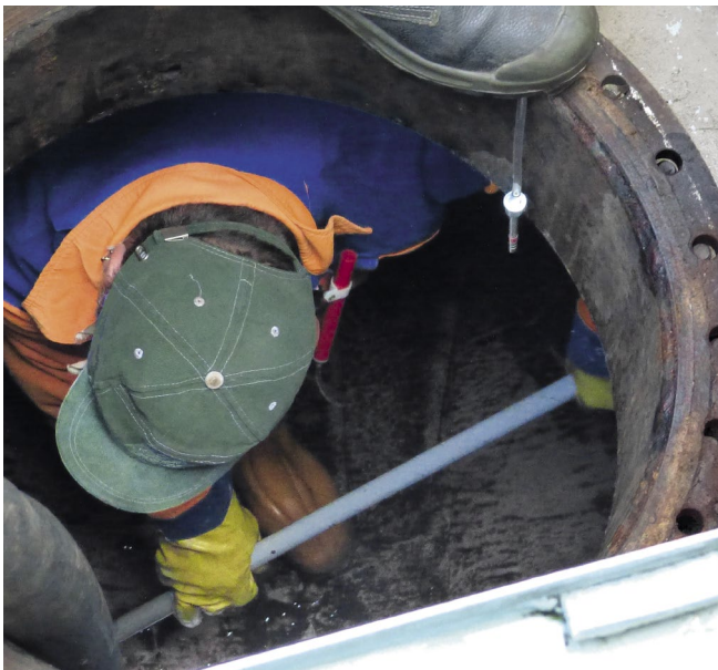
Abbildung 25: Innenreinigung eines Erdtanks
