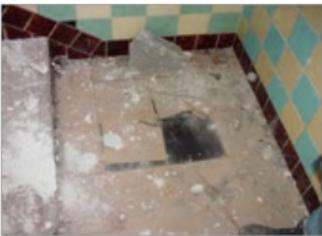
Sogenannte **Flexplatten** zählen zu den **asbesthaltigen Bodenbelägen**. Auch der hierfür verwendete Kleber ist nicht selten asbesthaltig.
