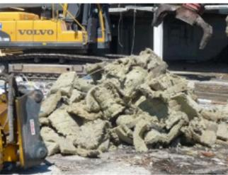
Früher wurden oft **Stein- oder Glaswolle** als Wärmedämmstoffe oder als Trittschalldämpfung eingebaut. Sie enthalten **künstliche Mineralfasern**.
