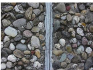
Fertigteile, wie Wände und Stützen bei Plattenbauten, wurden oft mit **Dichtmassen** verfugt, die teilweise große Mengen **PCB (Polychlorierte Biphenyle)** enthielten.
