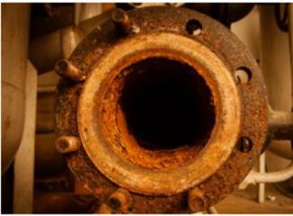
In **Flanschverbindungen** von Heizungen oder raumluftechnischen Anlagen finden sich **asbesthaltige Dichtungen**.
