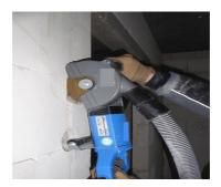
Bei Entstehung von Staub: Absaugung direkt an der Entstehungsstelle
