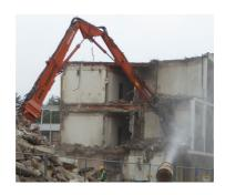
Zur Verminderung der Staubausbreitung: Befeuchtung mit Wasser bei Abbrucharbeiten
