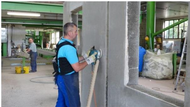
Abbildung 10: Nachbearbeitung einer Fertigwand
