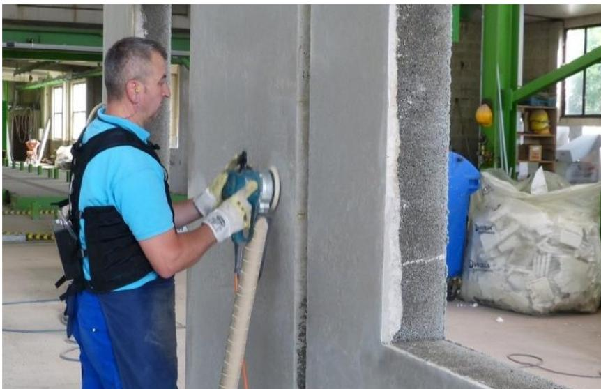
Abbildung 19: Nachbearbeitung einer Fertigbauwand mit einem abgesaugten Tellerschleifer
