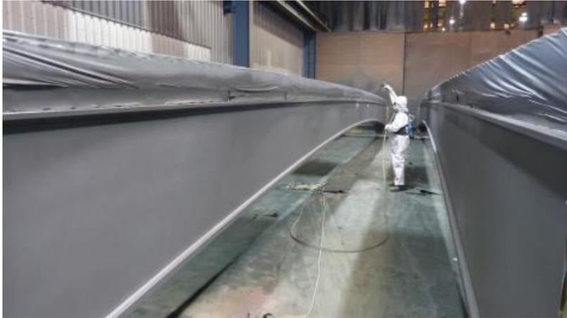
ABBILDUNG 5: FREIE LÜFTUNG BEIM SPRITZEN VON GROßBAUTEILEN
