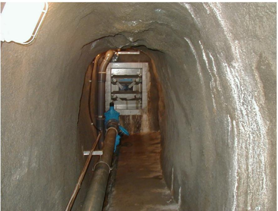
Trinkwasserentnahme aus einem Stollen
