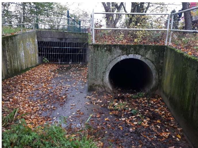
Abbildung 2: Südliches Ende der Münchbachverrohrung im Bereich der Einleitestelle des RÜB (Herbst 2019)
