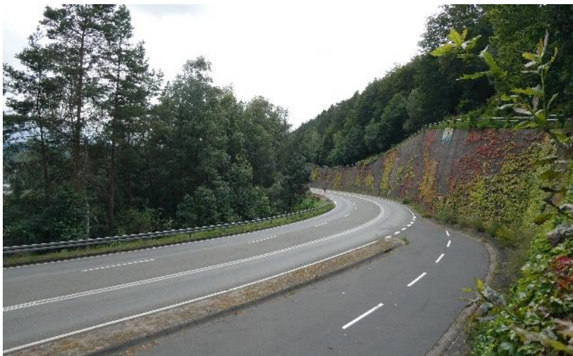
Abbildung 2: Panoramastraße und Parkbucht mit bergseitiger Stützmauer
