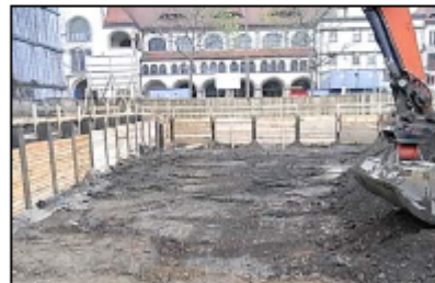
Abb. 4. Schichtenweiser Abtrag, verpflichtend bei baubegleitender KMR
