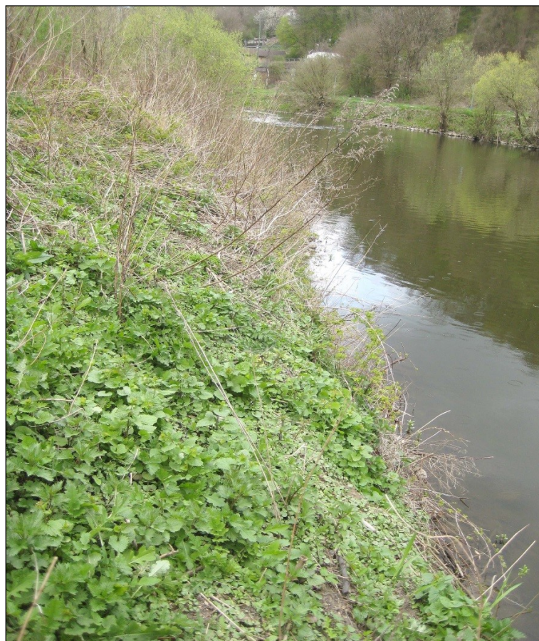
Abbildung 7: Steiler Uferabbruch am rechten Lahnufer
