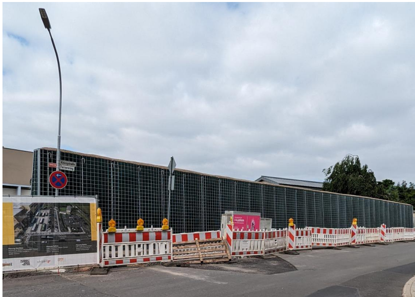
Abbildung 5: Im Bau befindliche Schallschutzmauer Kinzigstraße (Bild: [REDACTED])
