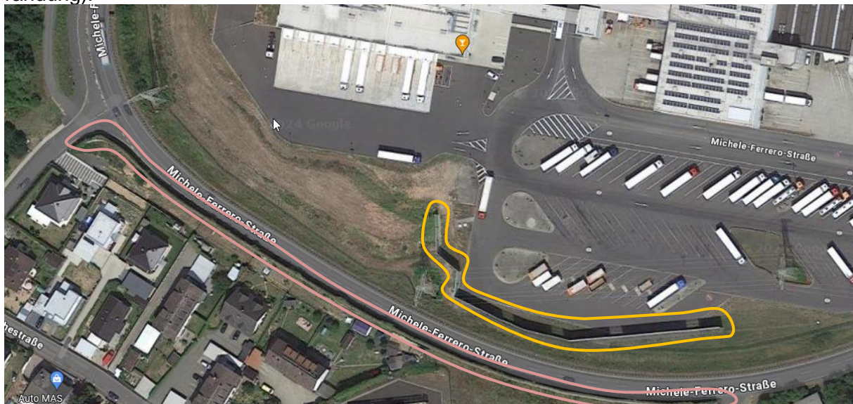
Abbildung 6: Lärmschutzwände zwischen Fa. Ferrero und Wohnbebauung Warthestraße Nord (Screenshot aus Google Maps)
