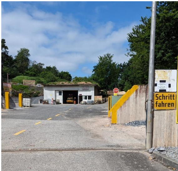
Abbildung 11: Blick auf das Betriebsgelände "Schüttgüter Stadallendorf" (Bild: [REDACTED])
