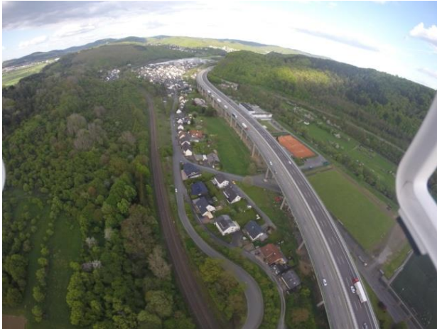
Abbildung 28 Talbrücke Sechshelden mit unterliegender Wohnbebauung 71
