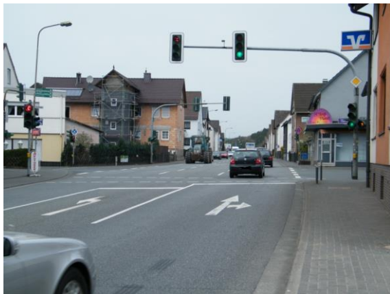
Abbildung 63 Ortstypische Bebauung in der Gemeinde Breidenbach 116
