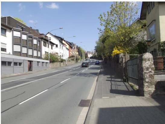
Abbildung 35 Wohnbebauung an der L 3451, Bergstraße in Wetzlar 82
