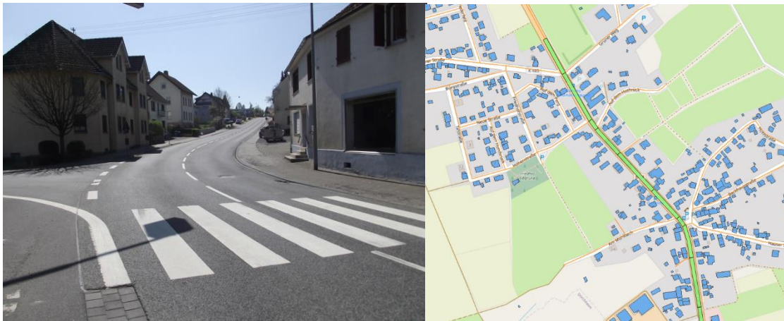
Abbildung 47 Bebauung entlang der B 54 in Elbgrund (links) und Visualisierung des Lärmkonfliktpunkts im Nachtzeitraum durch normierte, farbige Lärmkennziffernbänder (rechts) 97,98
