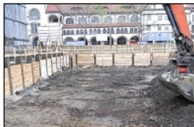
Abb. 4. Schichtenweiser Abtrag, verpflichtend bei baubegleitender KMR
