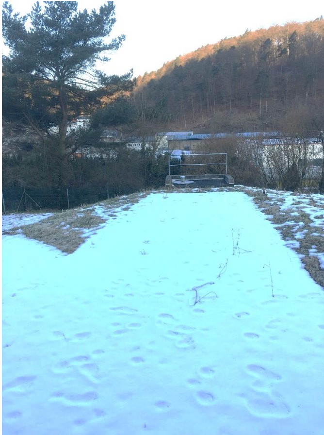
Abbildung 2-1: Foto der WSZ I Tiefbrunnen Niederscheld
