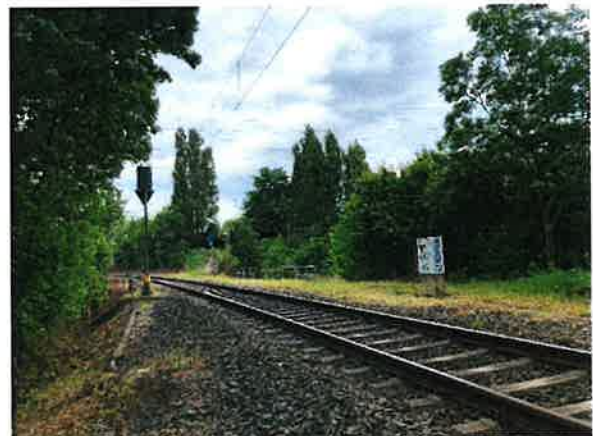
Abbildung 3: Bahnstrecke an der EÜ, Blick nach Westen
