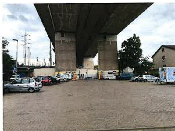
Abbildung 8: Südliche BE-Fläche Pflasterfläche
