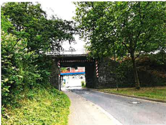
Abbildung 2: EÜ Lahnstraße II, Blick nach Osten
