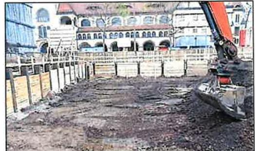
Abb. 4. Schichtenweiser Abtrag, verpflichtend bei baubegleitender KMR
