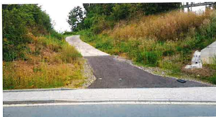
Bild 02: Zufahrt zum Bahngelände (Dammböschung auf dem Foto links wird künftig mittels Spundwand gesichert)
