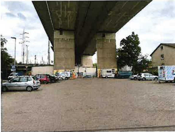
Abbildung 8: Südliche BE-Fläche Pflasterfläche
