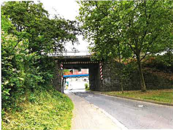
Abbildung 2: EÜ Lahnstraße II, Blick nach Osten
