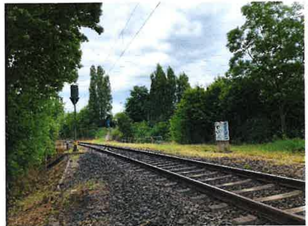
Abbildung 3: Bahnstrecke an der EÜ, Blick nach Westen
