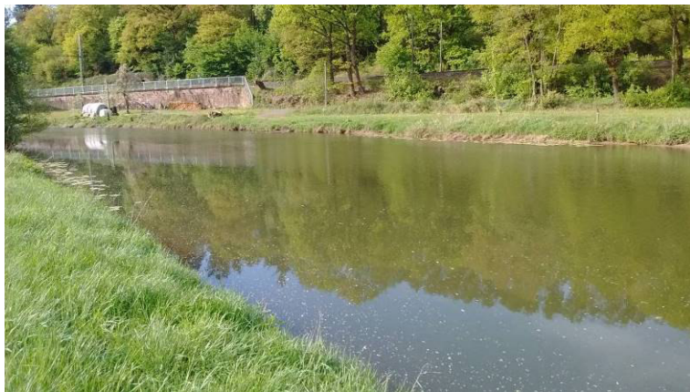
Abb. 2: Blick von oberhalb des Wehres in Richtung Nordwesten (27.04.2018).
