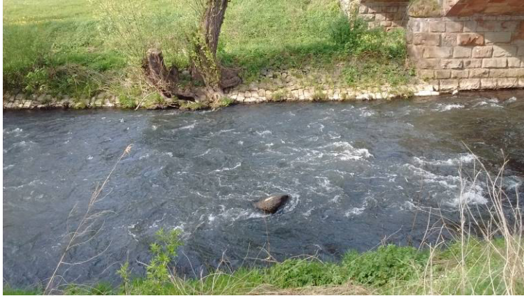
Abb. 6: Wehrsohlauslauf im Bereich der Brücke (27.04.2018).
