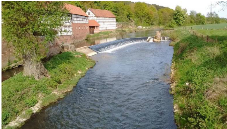
Abb. 1: Blick von der Brücke nach Osten auf das Wehr der Hainmühle (27.04.2018).
