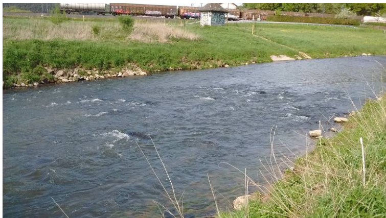
Abb. 4: Riffle-Habitat ca. 220 m unterhalb des Wehres. Oberhalb zu erkennen ist die Pegel-Messstation, die den Sohlverbau in diesem Bereich begründet (27.04.2018).
