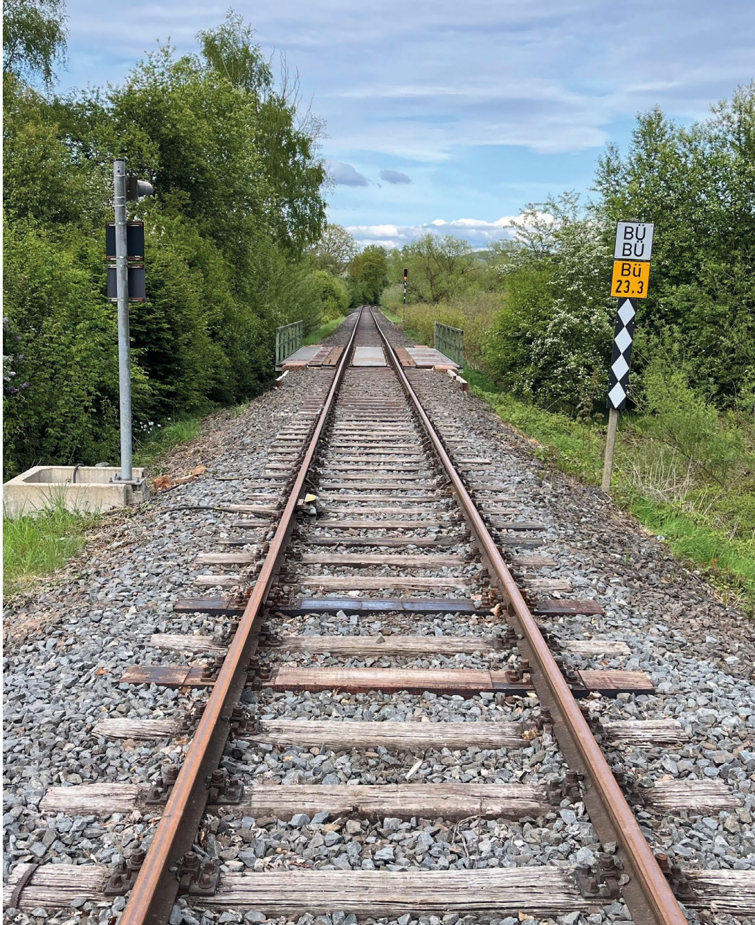
Foto: Die Trasse der aktuell stillgelegten Lumdatalbahn zwischen Lollar und Rabenau-Londorf ist durch das regional- planerische Ziel der Trassensicherung geschützt, um eine perspektivische Reaktivierung nicht zu erschweren oder gar zu verhindern. © RP Gießen – Jonas Goebel
