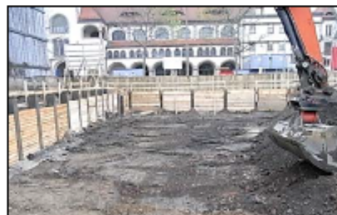
Abb. 4. Schichtenweiser Abtrag, verpflichtend bei baubegleitender KMR
