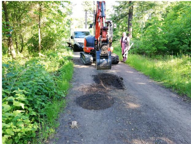
Bild 1: Lage des Baggerschurfes SCH 1 zwecks Ermittlung Aufbau der Wegbefestigung
