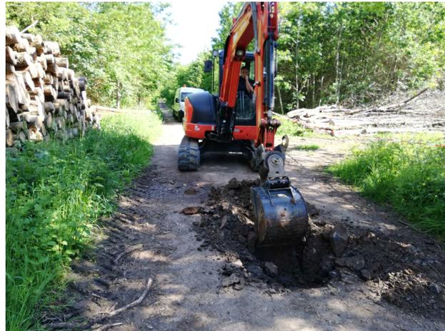
Bild 5: Lage des Baggerschurfes SCH 3 zwecks Ermittlung Aufbau der Wegbefestigung
