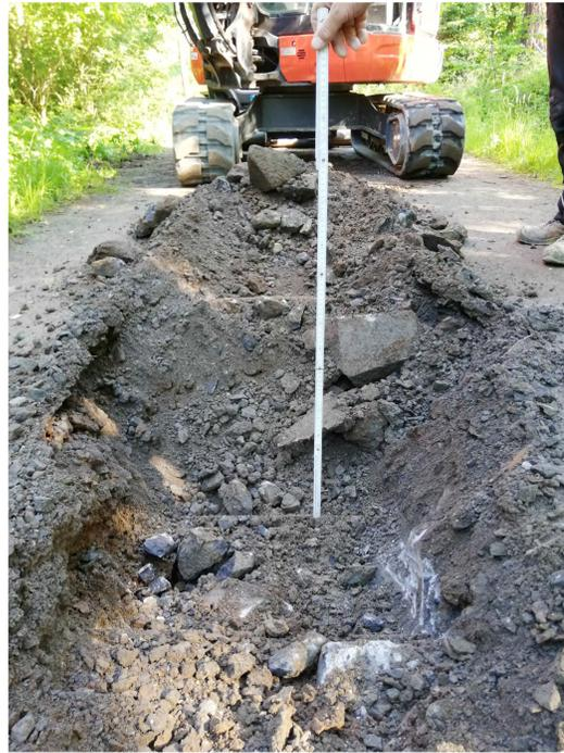
Bild 2: Schurf SCH 1 - bis in rd. 0,4 m Grobschlag aus Basaltbruchstücken.
