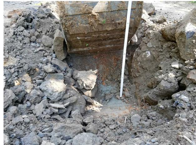
Bild 6: Schurf SCH 3 - rd. 0,4 m starker Schotter mit Grobschlag. Darunter Lehmboden.
