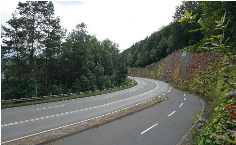
Abbildung 2: Panoramastraße und Parkbucht mit bergseitiger Stützmauer
