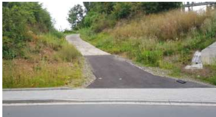
Bild 02: Zufahrt zum Bahngelände (Damböschung auf dem Foto links wird künftig mittels Spundwand gesichert)
