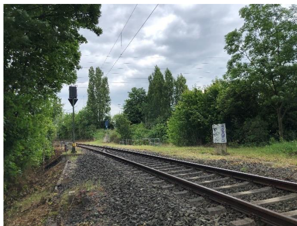
Abbildung 3: Bahnstrecke an der EÜ, Blick nach Westen
