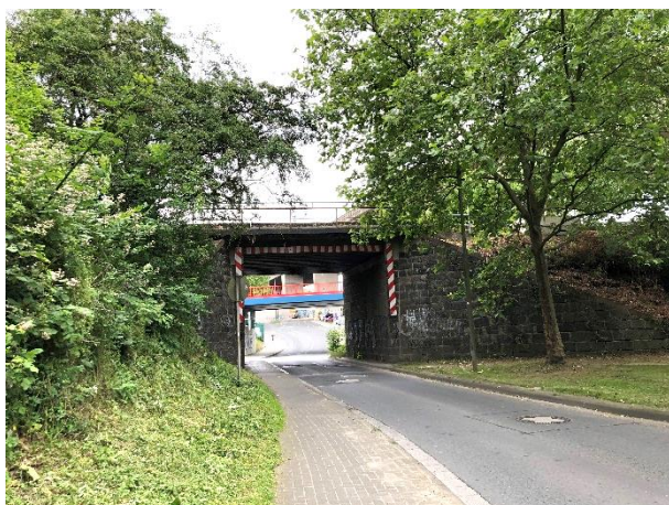
Abbildung 2: EÜ Lahnstraße II, Blick nach Osten
