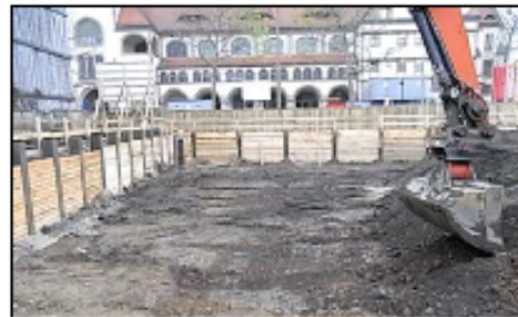
Abb. 4. Schichtenweiser Abtrag, verpflichtend bei baubegleitender KMR
