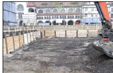
Abb. 4. Schichtenweiser Abtrag, verpflichtend bei baubegleitender KMR
