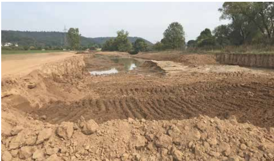
Abb. 98: Rohböden bei einer Großbaumaßnahme im Bereich der Lahn (Gisselbergerspanne bei Marburg) Foto: RP Gießen
